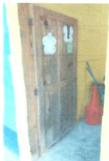
PUERTA, SUSTITUCION DE PUERTA DE COCINA, MODULO DE PARVULOS
