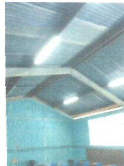
CUBIERTA DE LAMINA, SUSTITUCION DE CUBIERTA DE LAMINA EN MODULO DE PARVULOS
