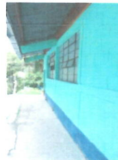
PINTURA, PINTURA EN MUROS EXT E INTERIORES DE MODULO PARVULOS
