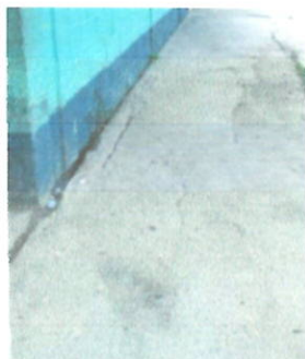
LOSA DE PATIO, REPARACION DE LOSA DE PATIO
